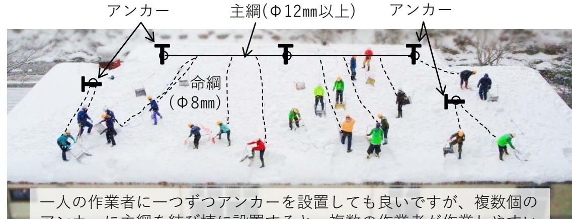
一人の作業者に一つずつアンカーを設置しても良いですが、複数個のアンカーに主綱を結び棟に設置すると、複数の作業者が作業しやすい環境がつくれます。
